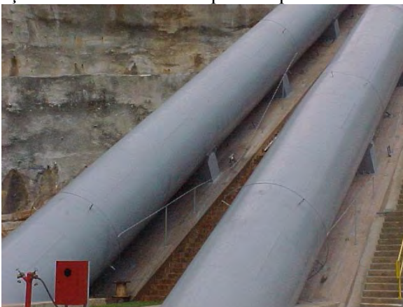
Figura 3 - Instalações para a medida de vazão usando o método de Gibson
